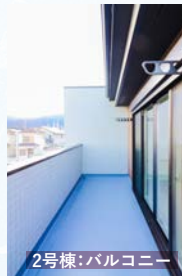
2号棟:バルコニー
